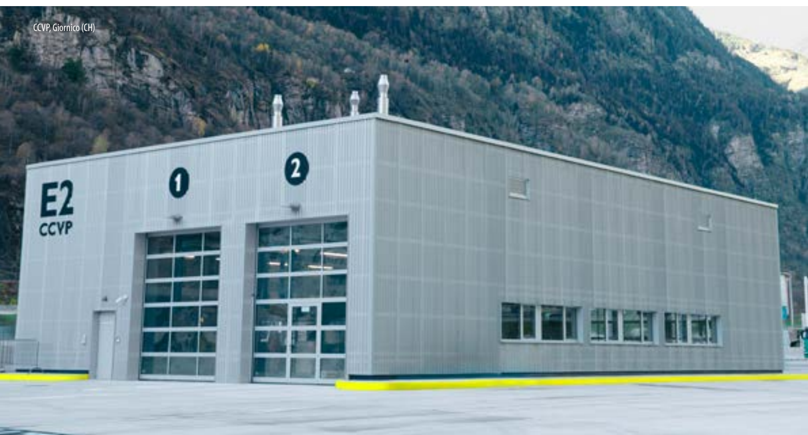
Sandwich verticale, profilato orizzontale
