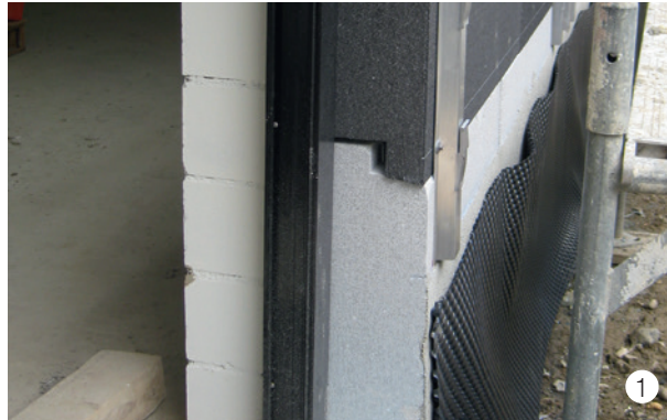
1 Sockelausbildung mit Sockeldämmplatte, mit seitlichem Stufenfalz und horizontaler Falzausbildung.
