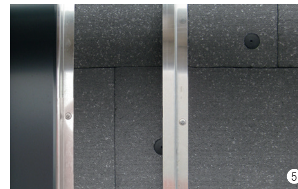
5 Tragprofile werden in den Kassettensteg verschraubt.
