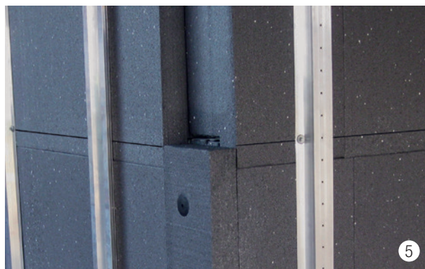
5 Eckausbildung, die Flächendämmung wird um die Vorsatzdämmung zurückversetzt und mit einer Eckdämmplatte winddicht verschlossen.
