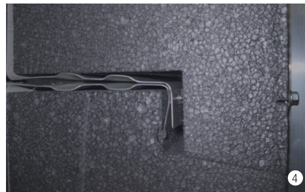
4 Die Befestigung der Tragprofile erfolgt mittels Schrauben in den Kassettensteg. Die Nut in der Dämmung dient als Orientierungshilfe.
