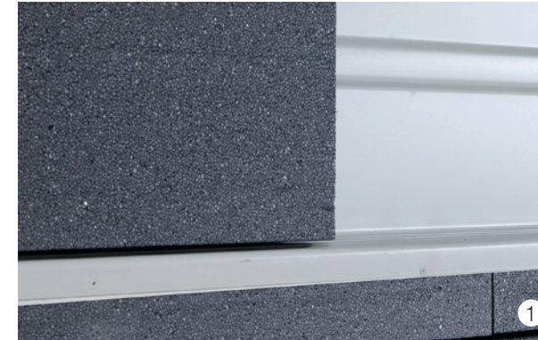
1 Kassettendämmung swissporLAMBDA Cassette in die MONTAWALL® MK x/333 einsetzen.
