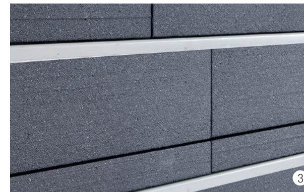
3 Kassettendämmung vollflächig montiert.
