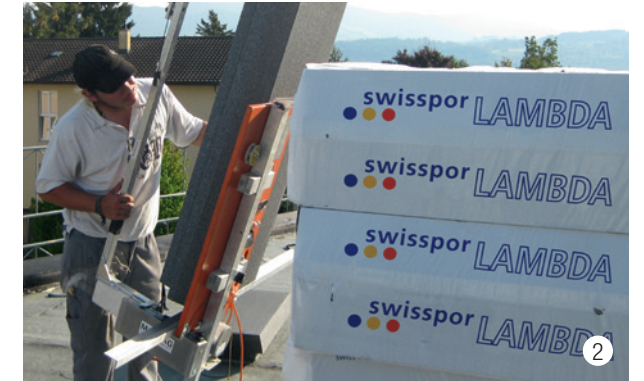
2 Die Dämmung kann mit einem Heissdrahtschneidegerät genau und einfach zugeschnitten werden.
