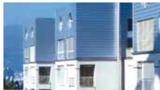
MONTAFORM® Wohnsiedlung, Olten (CH)
