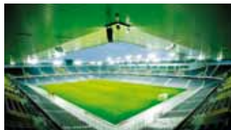
MONTAWALL® Stade de Suisse, Berne (CH)
