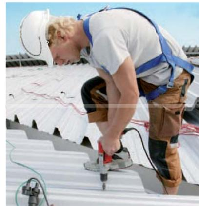
continu sont découpés sur le chantier, les zones découpées doivent être traitées ultérieurement à l'aide d'une laque de réparation, dans la mesure où elles sont visibles ou exposées aux intempéries après la pose.
