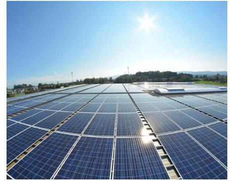
Wenn Sie PV-Module auf einer aus Colorcoat Prisma® oder Colorcoat HPS200 Ultra® bestehenden Dach- oder Wandfläche montieren möchten, sind nachfolgende Punkte zu beachten. Zunächst dürfen die Bereiche unterhalb der PV-Module nicht als "wartungsfrei" betrachtet werden. Des Weiteren hat die Montage der PV-Module derart zu erfolgen, dass eine effektive Wartung gewährleistet ist, wobei Wartungsprotokolle kontinuierlich vorgehalten werden müssen.
