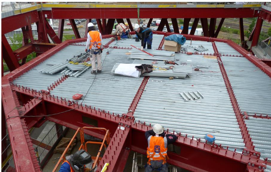
et rapidement aux conditions locales. Même le stockage des paquets SUPERHOLORIB® de seulement 60 cm de large aisément empilables n'a posé aucun problème pour ce chantier sis au centre-ville, cela grâce aux dimensions compactes du produit.
