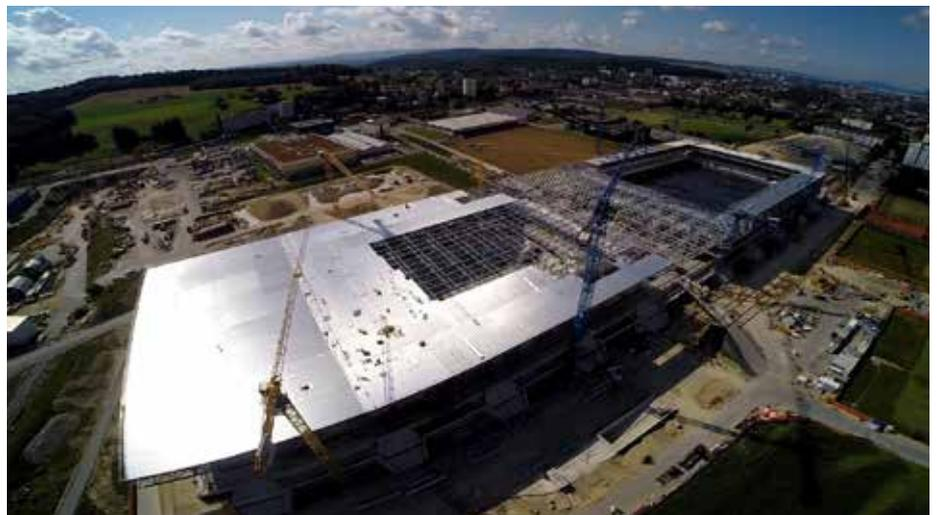
„Die Montage verlief einfach, obwohl,“ so räumt Hugues Steiner noch kurz ein, „das Anbringen der Paneele mit 15 Meter Lauflänge forderte schon unser ganzes Geschick. Aber da wir immer wieder mit Produkten der Montana Bausysteme AG arbeiten, ging auch diese Montage schliesslich zügig vonstatten“, erklärt der Fachmann.
