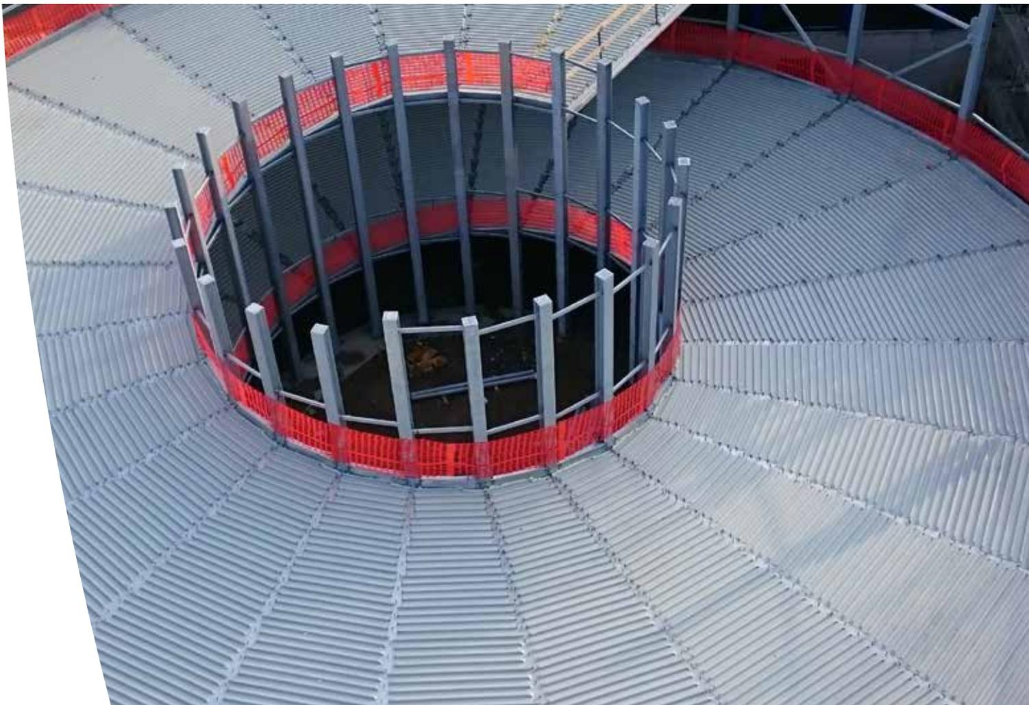
Da die Verbundprofile ab Werk in kompakt verpackten Bündeln angeliefert wurden, benötigten sie vor Ort lediglich eine geringe Lagerfläche und verursachten nur wenig Verkehr auf der Baustelle. Zudem erhöhte das geschossweise Verlegen der Bleche, welches unmittelbar nach der Montage der Tragkonstruktion erfolgen konnte, zusätzlich die Sicherheit vor Ort. Durch die genaue Vorfertigung, waren die Elemente problemlos und zügig zu montieren.
