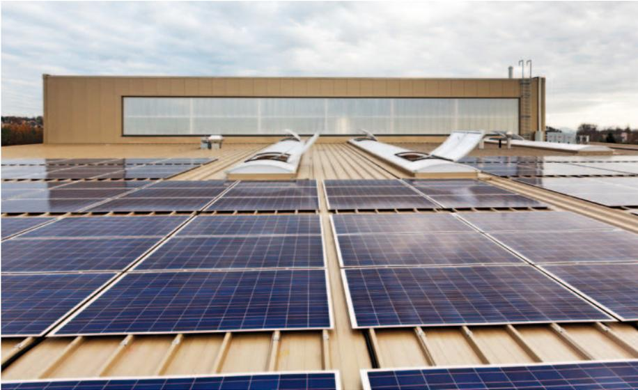
ebenfalls Rechnung getragen werden. Die Sandwichelemente verfügen über einen U-Wert von weniger als  $0,23 \text{ W/m}^2\text{K}$  und entsprechen somit dem von der SIA vorgegebenen Wert. Damit ist nicht nur die wärmedämmende Eigenschaft der Sandwichpaneele nachgewiesen, sondern sie bieten auch an heissen Tagen einen ausreichenden sommerlichen Wärmeschutz.
