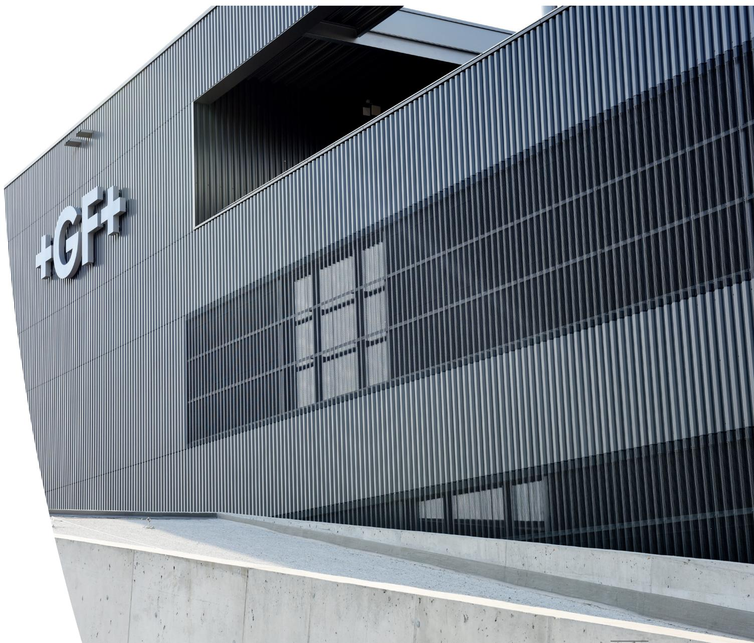
Sia le cassette MONTAWALL® sia i profili SWISS PANEL® presentano un ulteriore vantaggio; grazie alle loro superfici irregolari, i sistemi assicurano elevati valori di assorbimento acustico. Ultimo ma non meno importante, ciò si riflette efficacemente pure negli ampi cortili interni del nuovo edificio della GF, e offrono ai dipendenti un accogliente luogo dove riposare e raccogliere nuove e progressiste idee.
