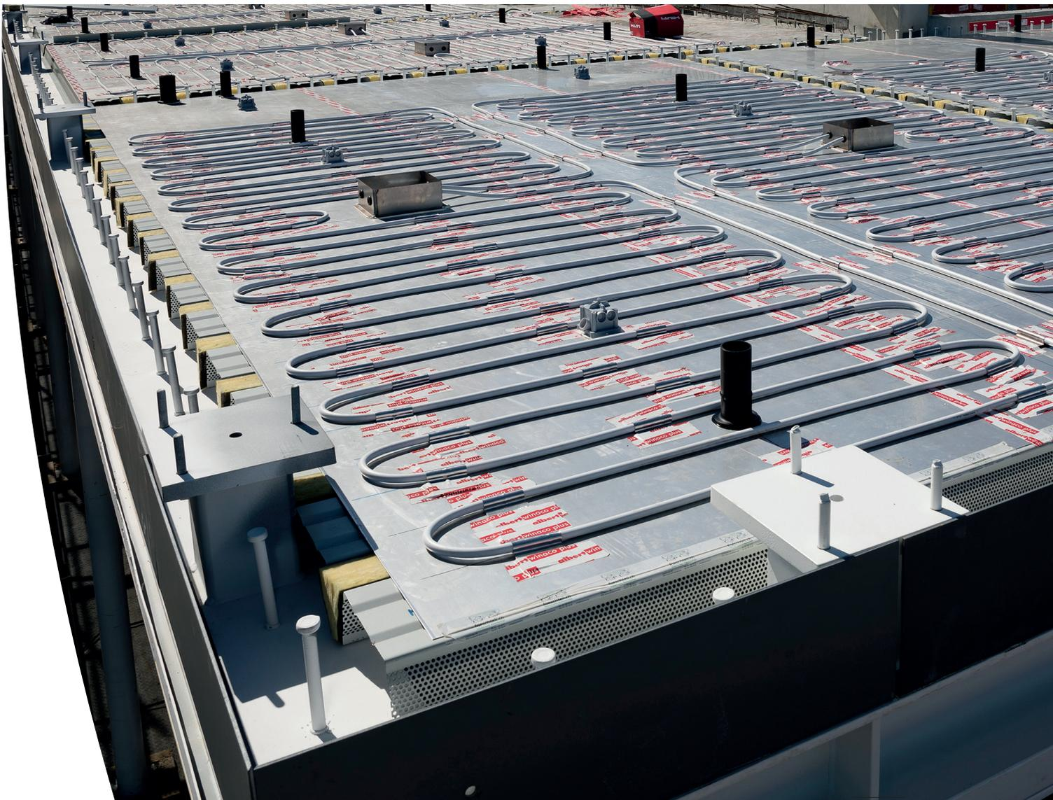
Über mehrere Wochen zog sich die Vorfabrikation vor Ort. Danach konnten die sperrigen Module mit einer Spezialvorrichtung in die Nähe des Krans transportiert und von dort in die Stahlkonstruktion des Cubics eingehoben werden. Nach dem Befestigen und Abdichten sowie dem Zusammenschluss der einzelnen Deckenfelder zu einem Gesamt-Deckensystem erfolgte mit der Überbetonierung der Module ein letzter Schritt zur Einbindung der individuell entwickelten und erstellten Zwischendecken.
