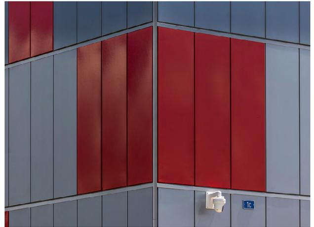
Pour le nouveau bâtiment de Courroux, près de 1'100 mètres carrés de revêtement de façade ont été réalisés avec des panneaux MONTALINE® de 500 millimètres de large de la désignation ML 26/500 F-K (avec joint ouvert) - et ce dans les deux teintes différentes "aluminium blanc" (RAL 9006) et "rouge carmin" (RAL 3002). Cette combinaison correspond aux directives de l'entreprise en matière de Corporate Design.
