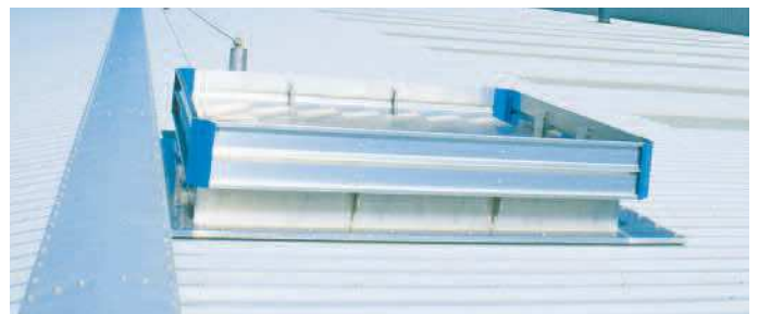
Durchbruch in der Dachdeckung
