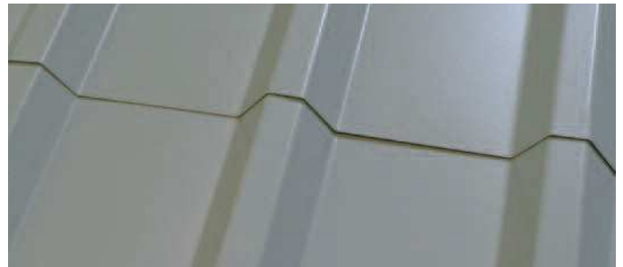
Schnittkante an einer Dacheindeckung
