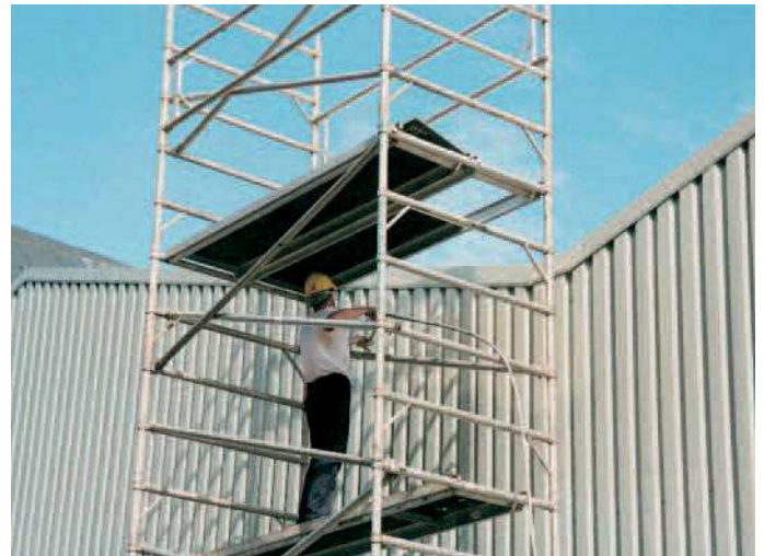
Überlackieren der Fassadenbekleidung
