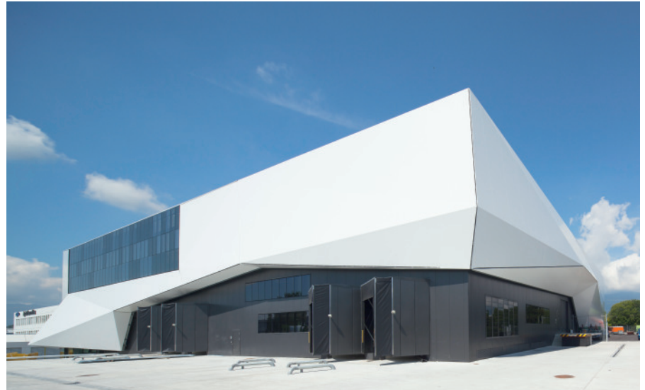
Bild 1: Sandwichelemente werden heutzutage auch bei repräsentativen Bauwerken eingesetzt (Halle logistique CICR, Satigny)
