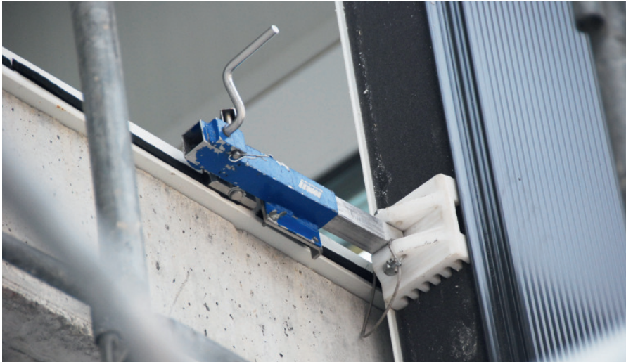
Bild 9: Montagewerkzeug zur Erzeugung des notwendigen Anpressdrucks
