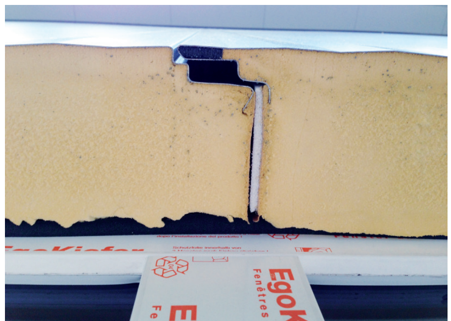
Bild 8: montagebedingt mangelhafte Fugenausbildung im Sturzbereich einer Fensteröffnung. Ohne Kontakt und ohne Kompression kann das Dichtband seine Funktion nicht erfüllen.
