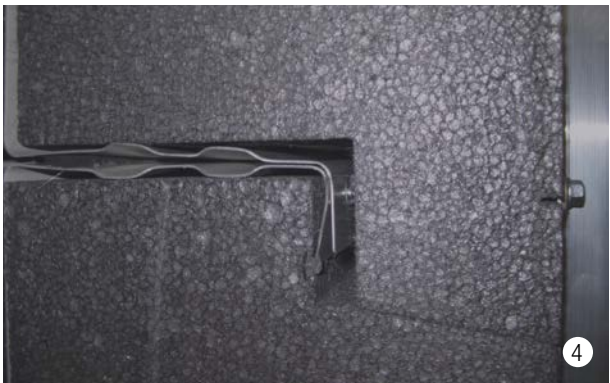
Il fissaggio del profilo portante avviene per mezzo di viti nell'anima della cassetta. La scanalatura nell'isolante serve come ausilio per l'orientamento.
