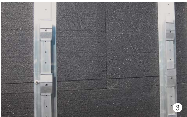
Posare l'isolante con min. 10 cm di sporgenza laterale e avvitare la sottostruttura nell'anima della cassetta.
