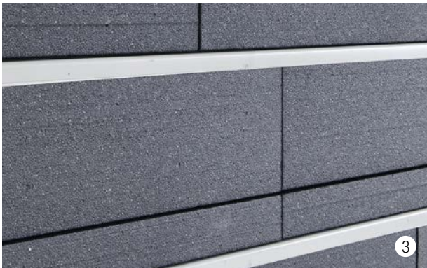
Isolante delle cassette applicato sull'intera superficie.
