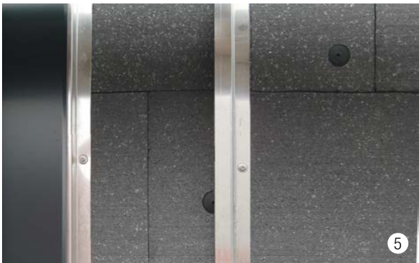
I profili portanti vengono avvitati nell'anima della cassette.
