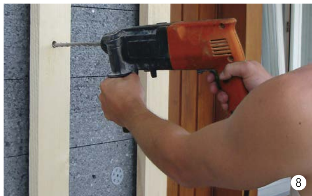
La listonatura portante/ventilata e il fondo di ancoraggio vengono preforati secondo i calcoli statici e le direttive del fornitore delle viti distanziatrici di sicurezza.
