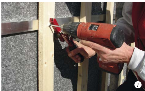
La listonatura portante/ventilata viene fissata sul profilo angolare orizzontale per mezzo di viti in metallo per legno.
