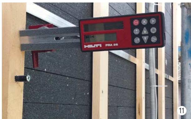
Allineamento della listonatura, per es. con un laser rotativo.
