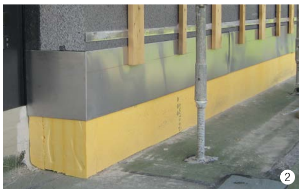
Base della facciata con isolamento dello zoccolo swissporXPS e copertura in lamiera
