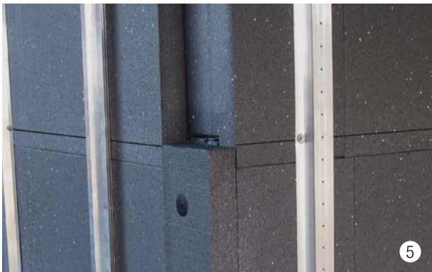
Formazione d'angolo: l'isolante superficiale viene arretrato intorno all'isolamento addizionale e chiuso con una lastra isolante angolare a prova di vento.
