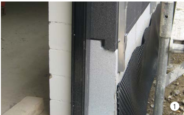
Formazione dello zoccolo con lastra isolante, con battuta laterale e predisposizione per la battuta orizzontale.
