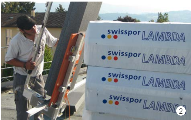
L'isolante si taglia con facilità e precisione facendo uso di un apparecchio da taglio a filo incandescente.
