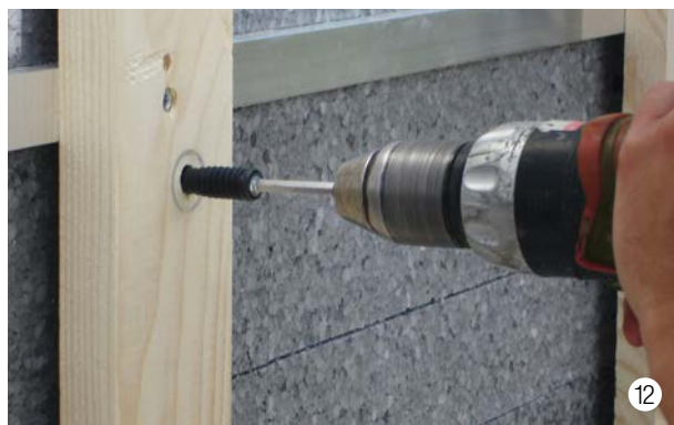
Appena realizzato l'allineamento della sottostruttura si esegue il fissaggio definitivo dell'ancoraggio.
