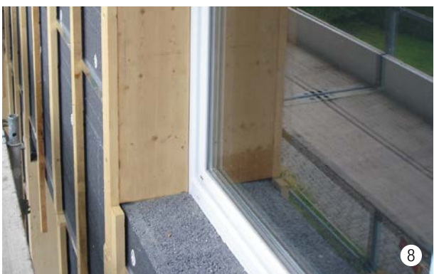
Formazione intradosso con lastra monostrato a lista intera
