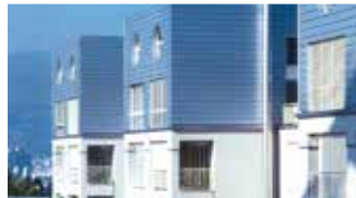
MONTAFORM® Wohnsiedlung, Olten (CH)
