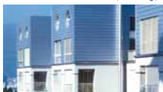
MONTAFORM® Wohnsiedlung, Olten (CH)
