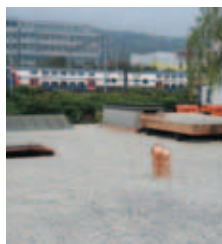
Nouvelle construction du toit plat à Pfäffikon, SZ
