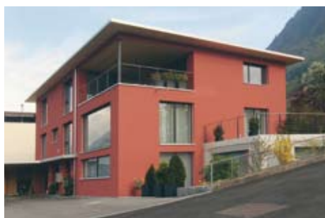
La rénovation intégrale des immeubles génère une plus-value et réduit les besoins en énergie.
